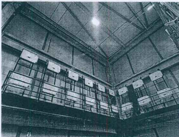
Slika 3. Izgled ugrađenih invertora objektu VOLI II
