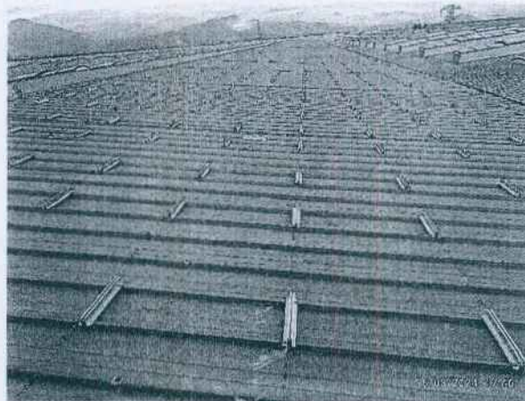
Slika1. Izgled konstrukcije za jedan string
